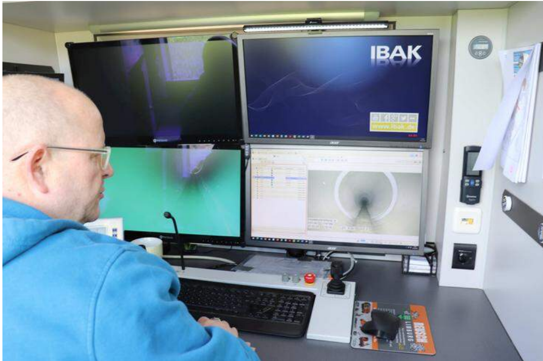
Ronald Lotz von der Firma Reusch beobachtet auf dem Monitor, welche Bilder die Kamera auf ihrem Weg durch den Kanal aufnimmt. Eventuelle Schäden vermerkt er in einem Protokoll. (© Dorothee Henche)
